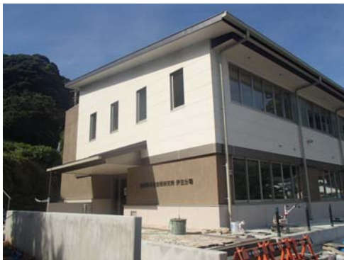
↑ 玄関側からみる新庁舎
