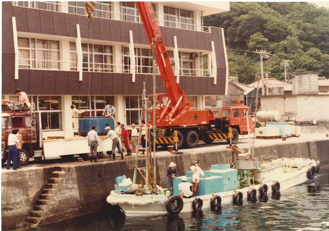
写真3 昭和56年の田子地区での沖出し作業の様子
