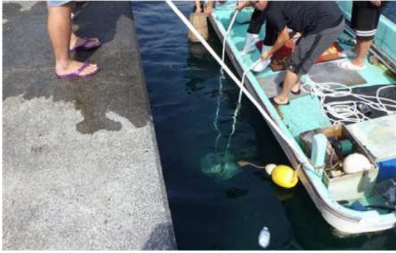
写真3 左：潜水作業なしで設置
