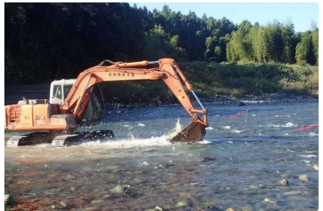
重機による河床耕耘の様子
