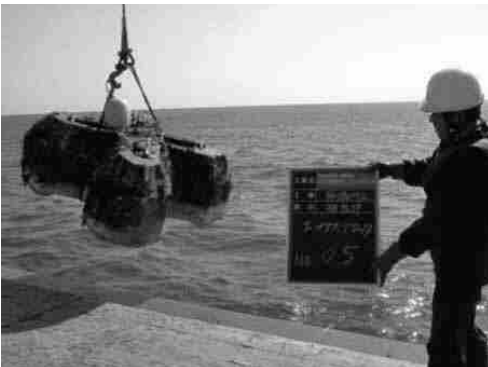
写真6 クレーンを使った藻礁の敷設
