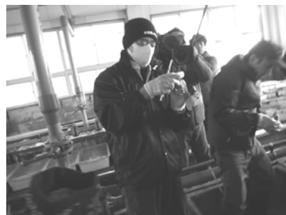
貼り付け作業風景
