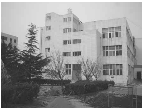
練り製品工場等が入居するビル
