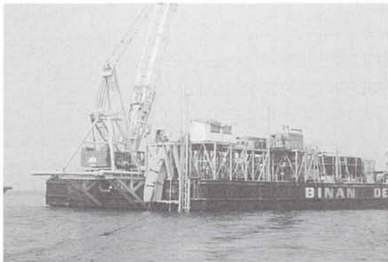
写真1 取水管敷設台船「天山」
