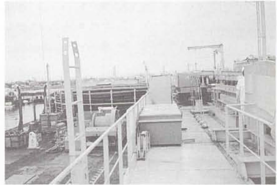
写真2 台船上の取水管 (左奥)
