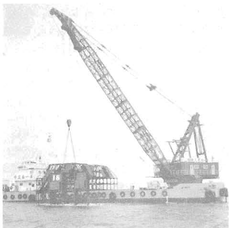
写真2 人工魚礁投入作業 (鋼製組立魚礁)
