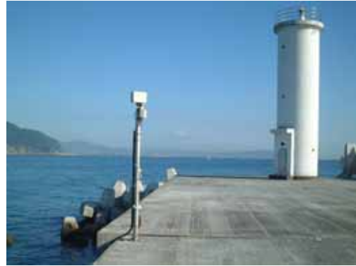
図 小川港防波堤の水温連続観測装置
