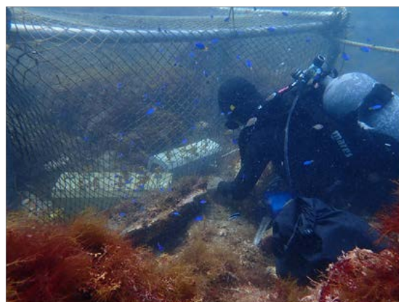
図 6 食害防除カゴ設置作業
