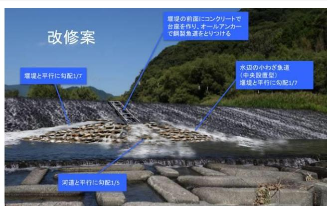
【ポイント】・補修を兼ねること、2種の魚道を併用することで費用を抑えている。
