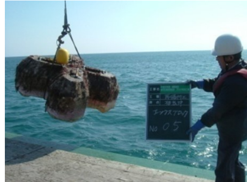
図4 クレーンを使って敷設
