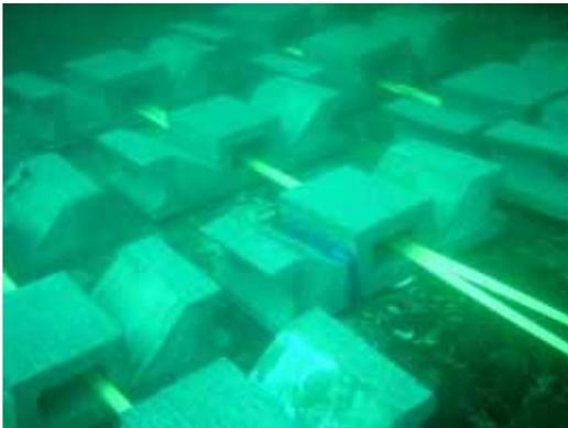
凹凸加工をした浮泥対策ブロック
